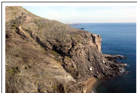
Deslizamiento y desplomes producidos por la acción de las olas sobre la base de los acantilados
